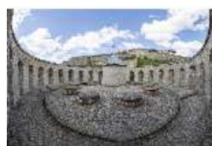
WüFg.I, Maschikulturm, oberstes Geschoss, DI029886, BSV-
