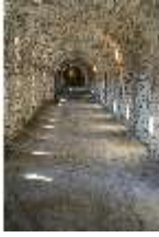
WüFg.II, Kasematte unterhalb der Festungsanlage, langer Flur, DI029909, BSV-
