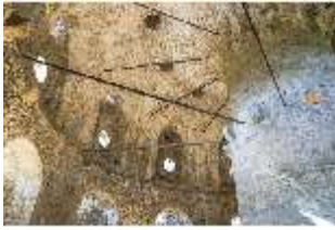
WüFg.II, Maschikulturm von innen, Blick aufs Gewölbe, DI029896, BSV-
