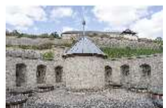
WüFg.I, Maschikulturm, oberstes Geschoss, DI029887, BSV-
