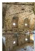
WüFg.II, Maschikulturm von innen, DI029894, BSV-
