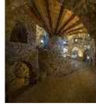
WüFg.II, Maschikulturm von innen, unteres Geschoss, DI029903, BSV-
