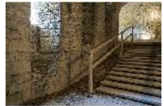
WüFg.II, Treppe in der Kasematte, DI029907, BSV-
