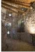
WüFg.II, Maschikulturm von innen, oberes Doppelgeschoss, DI029902, RSV-
