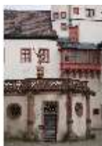
WüFg.I, Brunnenbau, DI016021, BSV-
