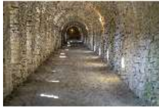
WüFg.II, Kasematte unterhalb der Festungsanlage, langer Flur, DI029910, BSV-
