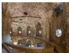
WüFg.II, Maschikulturm von innen, DI029882, BSV-
