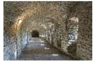
WüFg.II, Flur in der Kasematte unterhalb der Festungsanlage, DI029913, BSV-
