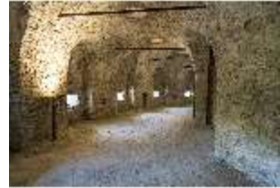
WüFg.II, Maschikulturm von innen, unteres Geschoss, DI029900, BSV-
