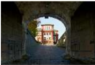
WüFg.I, Kommandantenbau (21), DI000793, BSV-
