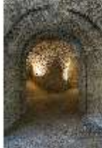
WüFg.II, Maschikulturm von innen, unteres Geschoss, DI029899, BSV-
