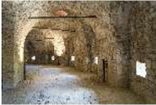
WüFg.II, Maschikulturm von innen, unteres Geschoss, DI029898, BSV-
