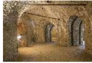
WüFg.II., Maschikulturm von innen, unteres Geschoss, DI029897, BSV-
